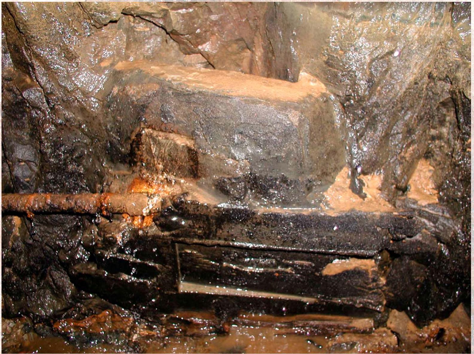
Alte Quellfassung ca. 5 Meter vom Stolleneingang
