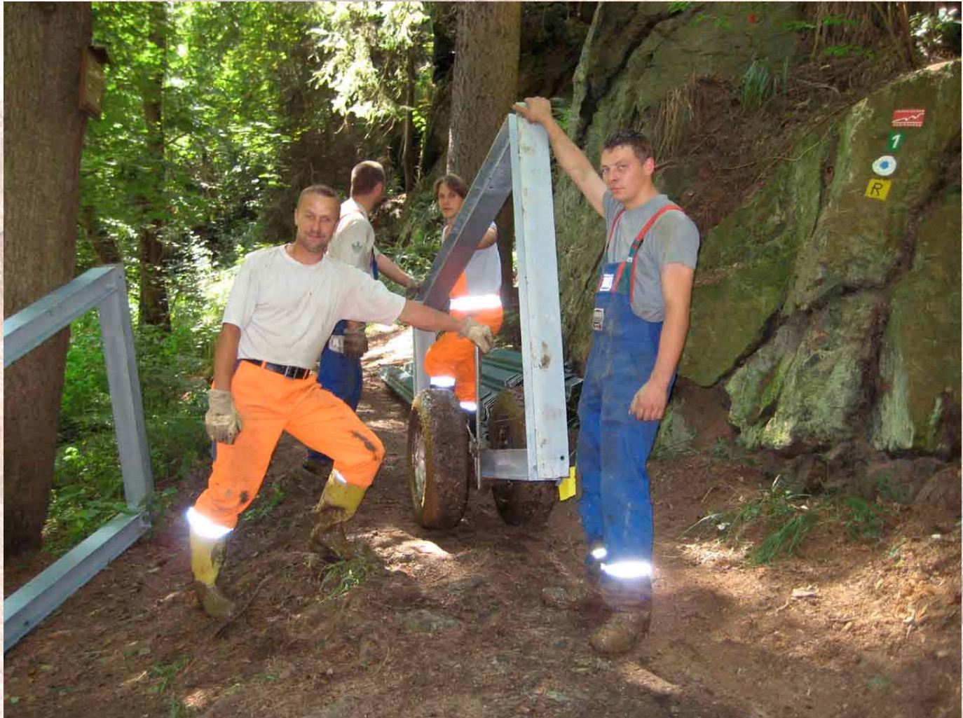
Transport der Verstrebungen für den Stollenvorbau durch Arbeiter der Fa. Träger und der Stadt Arzberg
