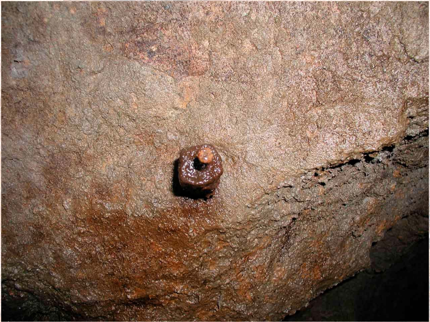
Holzstück in der Decke mit Schraube - evtl. Isolator für alte Beleuchtung
