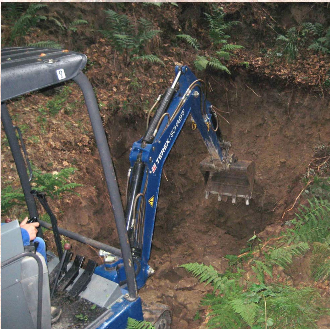
Stollenöffnung durch die Fa. Dötsch
