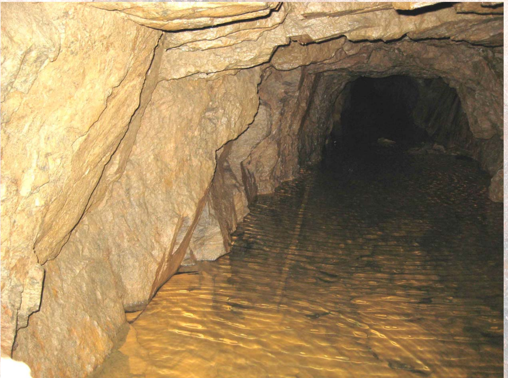
Stollen nach Öffnung mit Wasserstand von ca. 1 Meter
