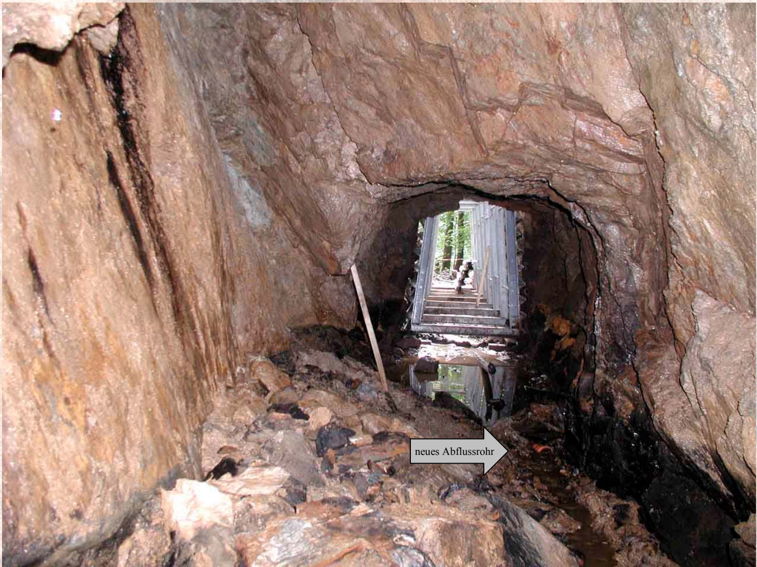
Stollenmundloch mit Vorbau nach teilweiser Trockenlegung
